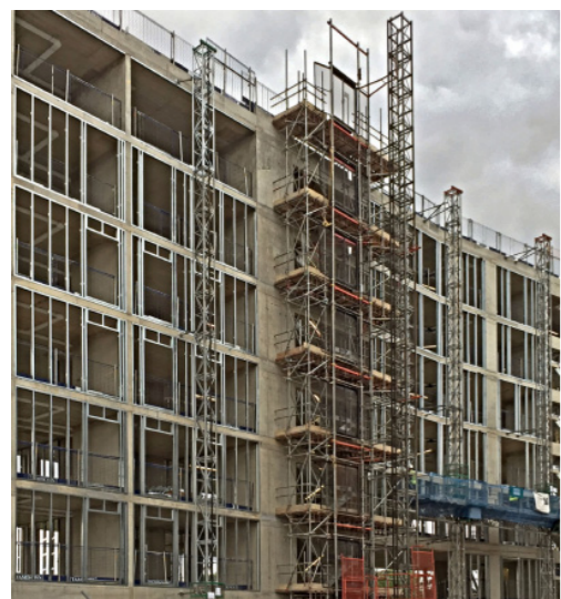
01 RC Concrete Frame/ Metsec Façade Walling
